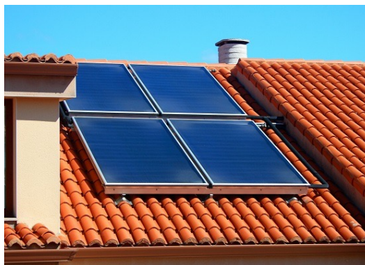
Figura 3.8. Izquierda: colectores de capa plana (Ecofener, 2020a), derecha: componentes de un colector (Rodríguez Galbarro, s.f.).
