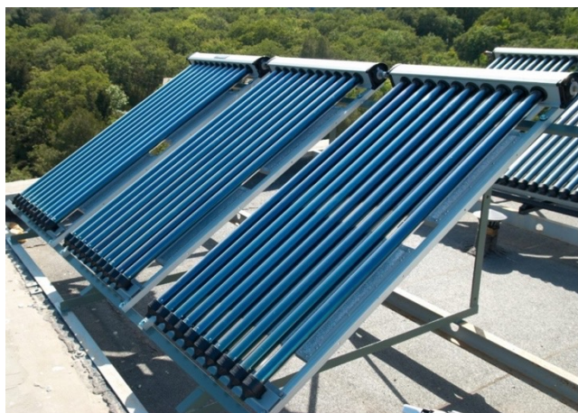
Figura 3.9. Izquierda: colectores de tubo (Álvarez, 2021), derecha: principio de funcionamiento (Sopelia, 2017).
