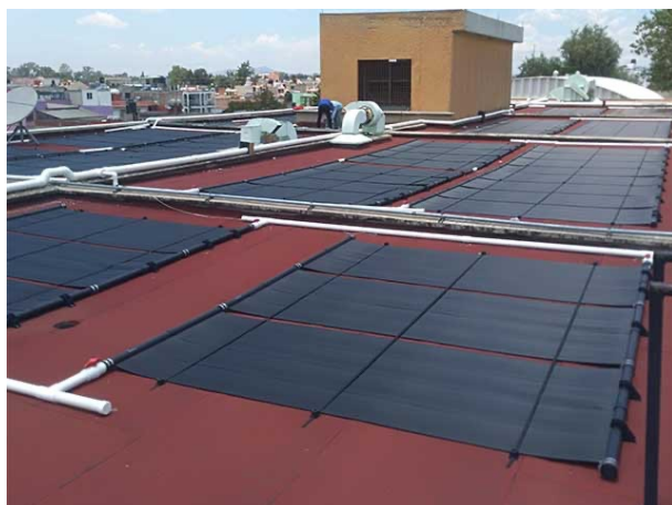
Figura 3.10. Izquierda: Principio de funcionamiento de los tubos heat pipe (Refrinoticias, 2014), derecha: colectores solares de plástico para albercas (Abha Albercas, s.f.).
