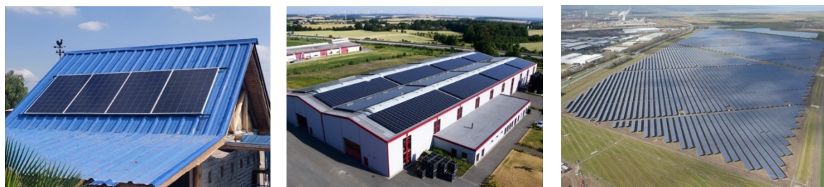
Figura 2.3. Clasificación por tamaño y uso: izquierda: sistema residencial (Solhé, 2020), centro: sistema industrial (Timestech, 2020), derecha: parque solar (Stocker, 2016).
